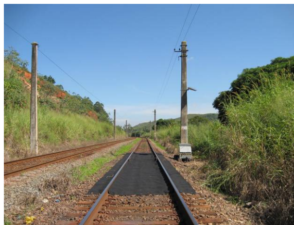
Figura 03 – Lubrificador face de bitola.
