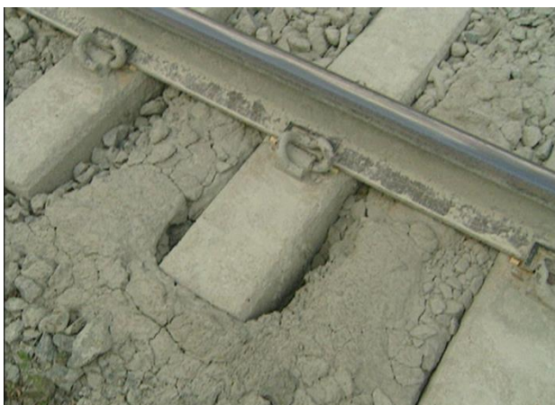
Fig. 15 Destruição do lastro pelo excesso de p(x) .
