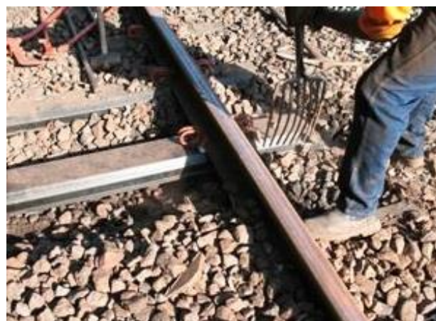
Fig 19 Substituição à oito de DM por DA na EFVM
