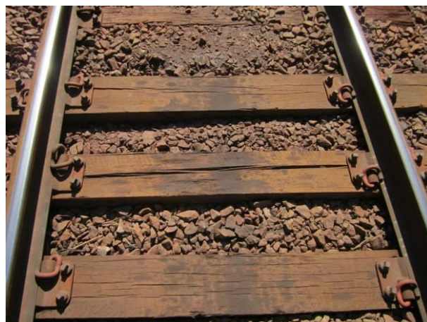
Fig. 6 D. Eucalipto, fendilhamento do corpo
