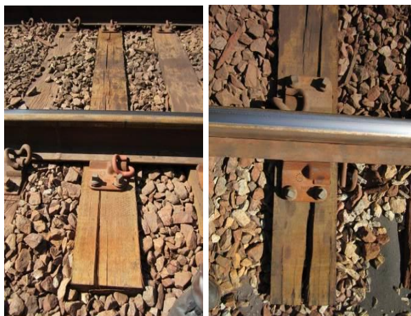
Fig. 5 D. Eucalipto, fendilhamento das extremidades passando pelos furos de pregação.
