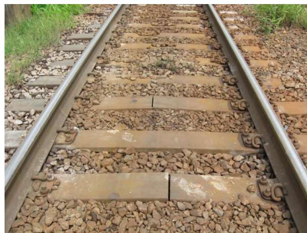
Fig. 9 Grupo (clustering) de DPR de bitola larga fraturados no modo “center bound”.
