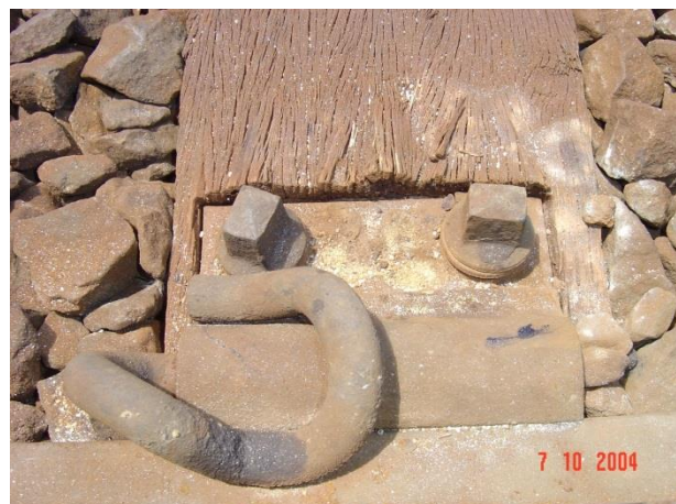
Fig. 2 Placa de apoio cortando a madeira.
